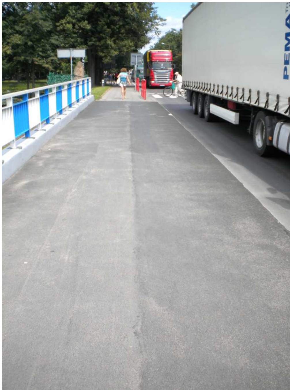
Rys. 3-8. Izolacja nawierzchnia poliuretanowo-asfaltowa
