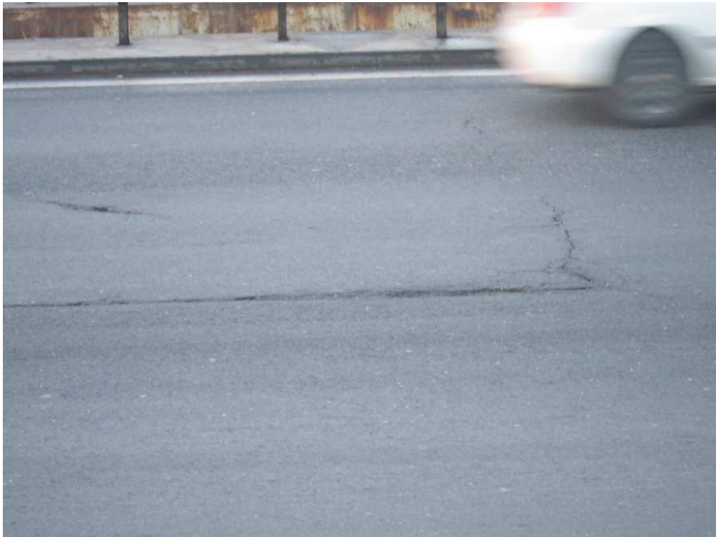
Rys. 3-12. Spękanie podłużne
