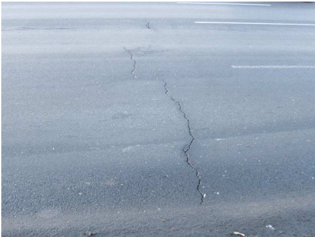
Rys. 3-11. Spękania poprzeczne
