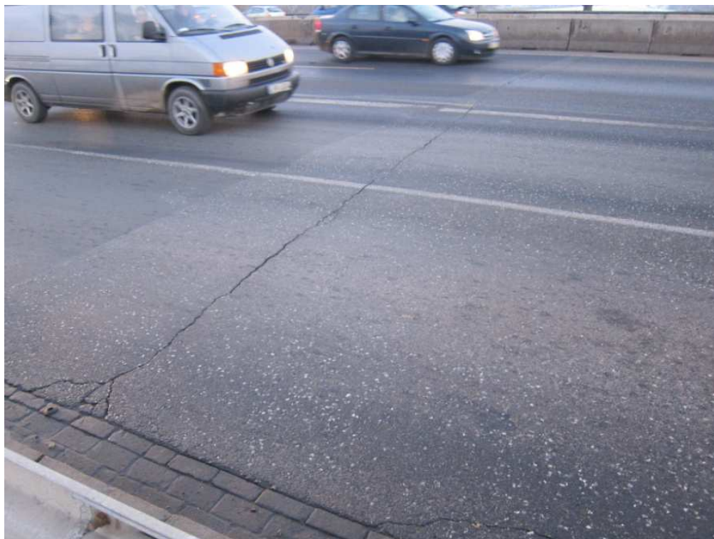
Rys. 3-14. Spękanie poprzeczne
