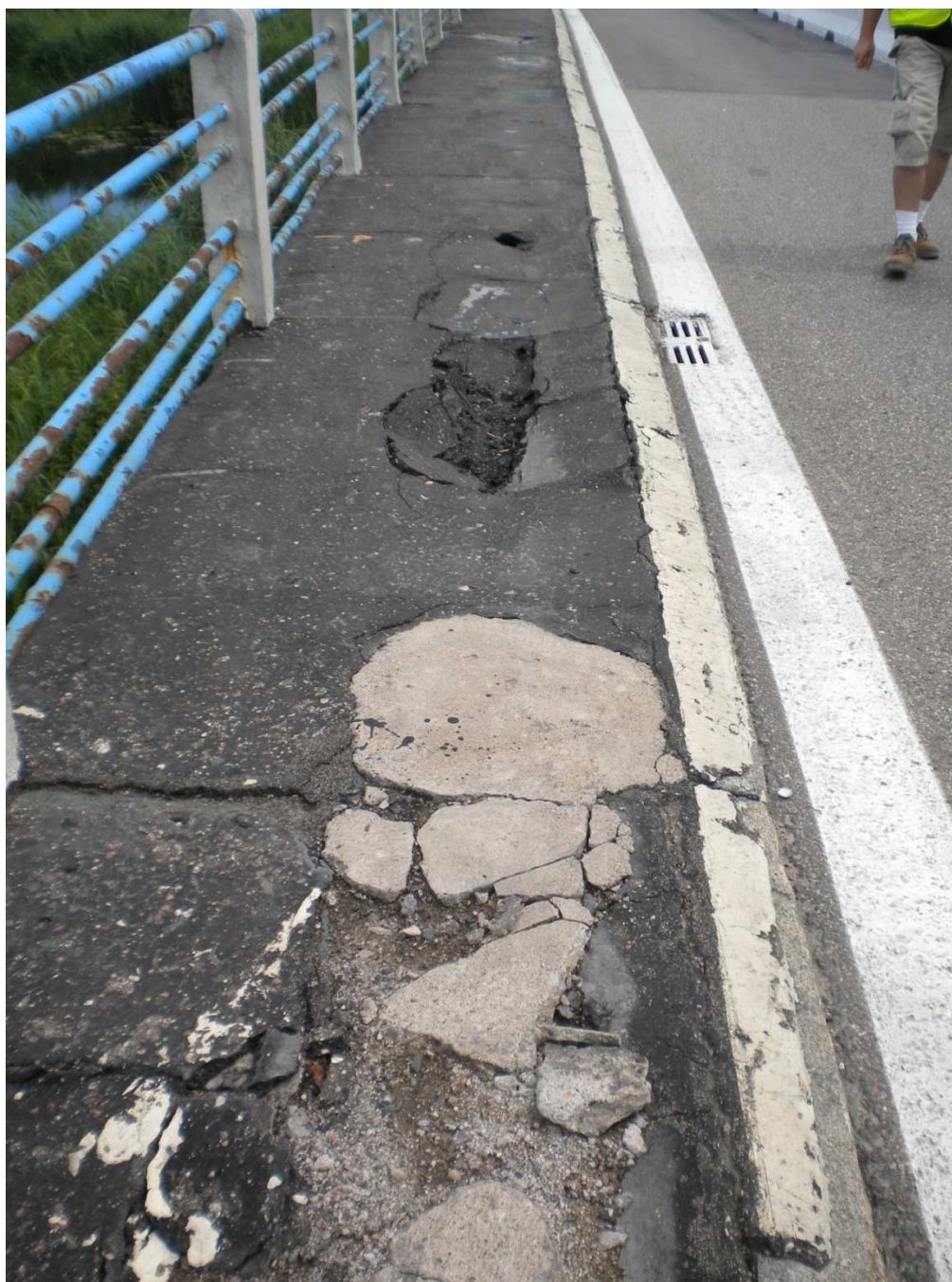
Rys. 3-3. Nawierzchnia chodnika na moście w Sztabinie
