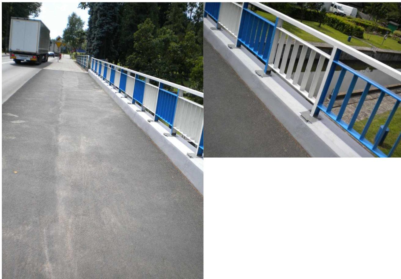
Rys. 3-7. Izolacja nawierzchnia poliuretanowa - widok ogólny powierzchni chodnika, prawidłowo wykonane połączenie nawierzchni z krawężnikiem
