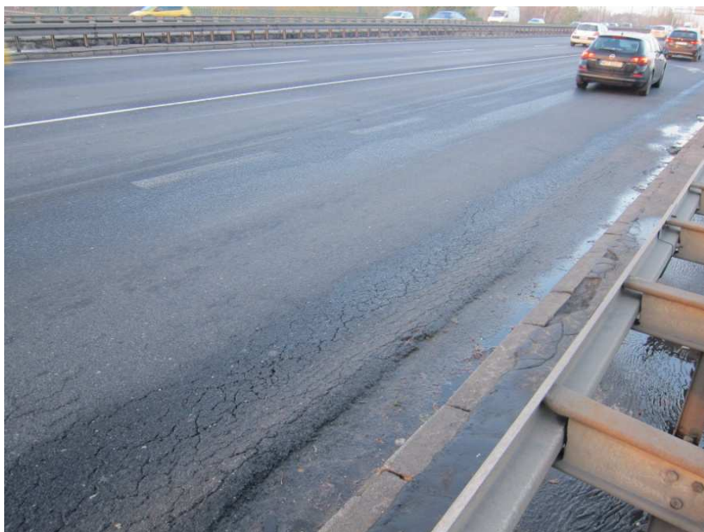
Rys. 3-10. Koleiny i fałdy przykrawędziowe ze spękaniami siatkowymi
