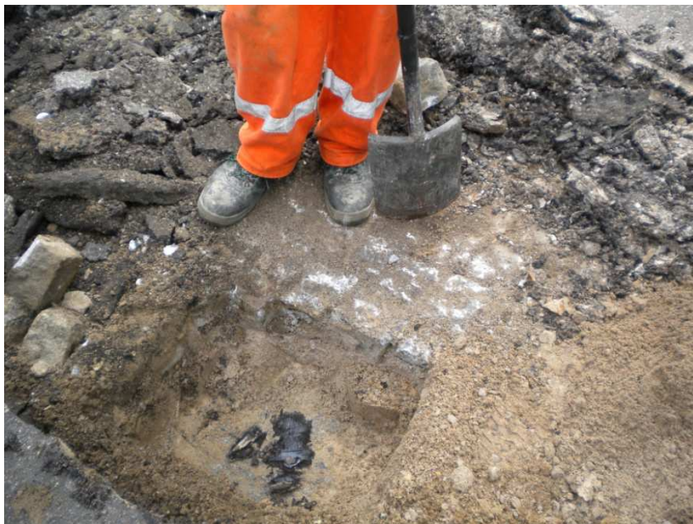
Rys. 3-5. Odkrywanie istniejącej konstrukcji nawierzchni warstw: kostki granitowej, posypki piaskowej, betonu ochronnego i izolacji z papy smołowej
