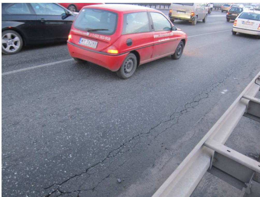
Rys. 3-15. Spękania siatkowe w prawym śladzie koła
