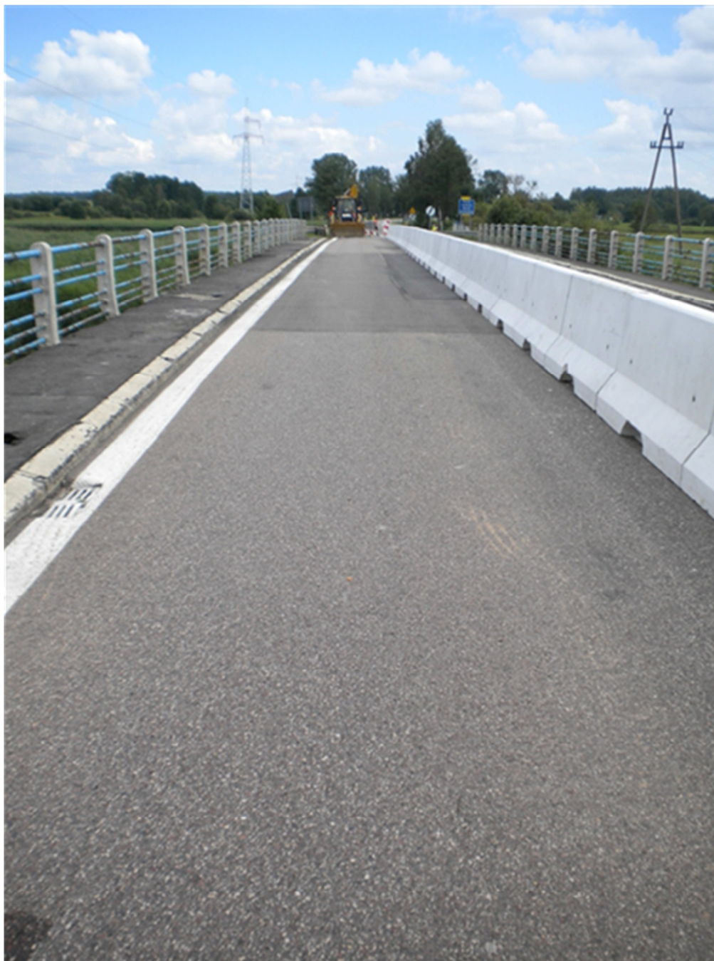
Rys.3-2. Nawierzchnia jezdni na moście w Sztabinie
