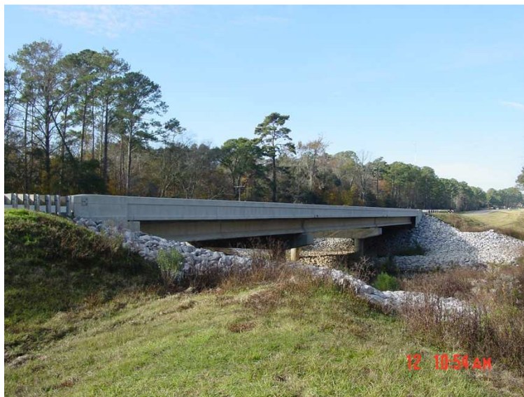
Rys. 2-9. Widok mostu nad strumykiem Mosquito (USA) [31]
